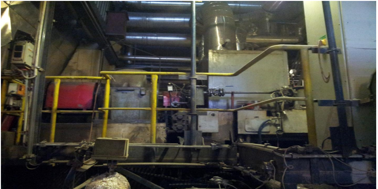
&lt;High Pressure Steam으로 동작하는 Axial Fan&gt;
