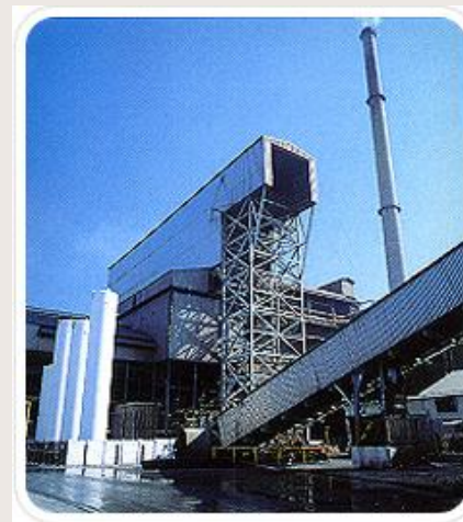
Ceramic Filter적용 집진기 (귀금속 제조사)
