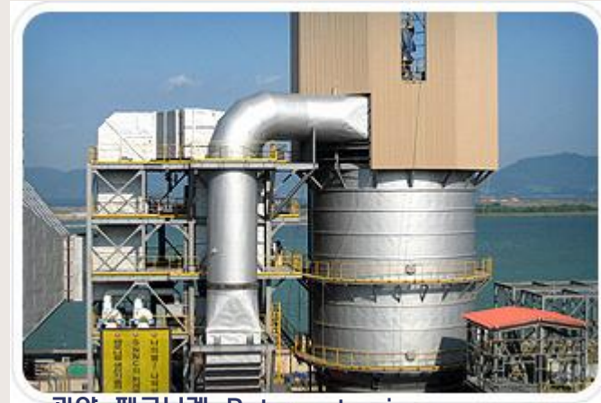
광양 페로니켈 Rotary atomizer
